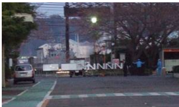
写真 4-2 試作看板の設置状況(全体)
