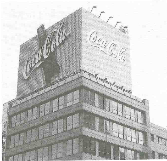
図4・3 完成した屋上広告塔
