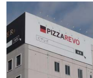
クロスメディアを活用する。詳細の事業内容はインターネットへ誘導する。
