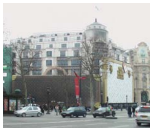
ルイヴィトン改装中の工事仮囲い。ブランドイメージを一瞬でも崩すことがない。
